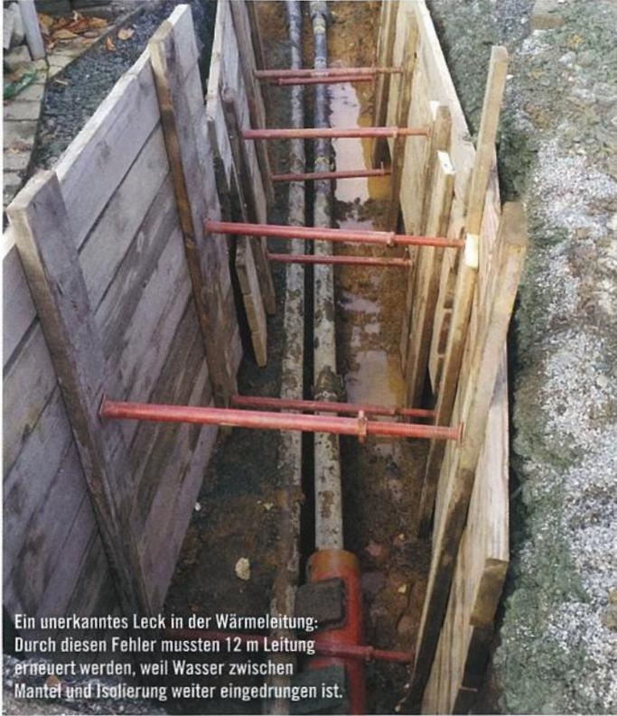
Ein unerkanntes Leck in der Wärmeleitung: Durch diesen Fehler mussten 12 m Leitung erneuert werden, weil Wasser zwischen Mantel und Isolierung weiter eingedrungen ist.
